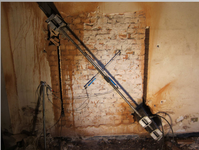
Realizzazione in sito
