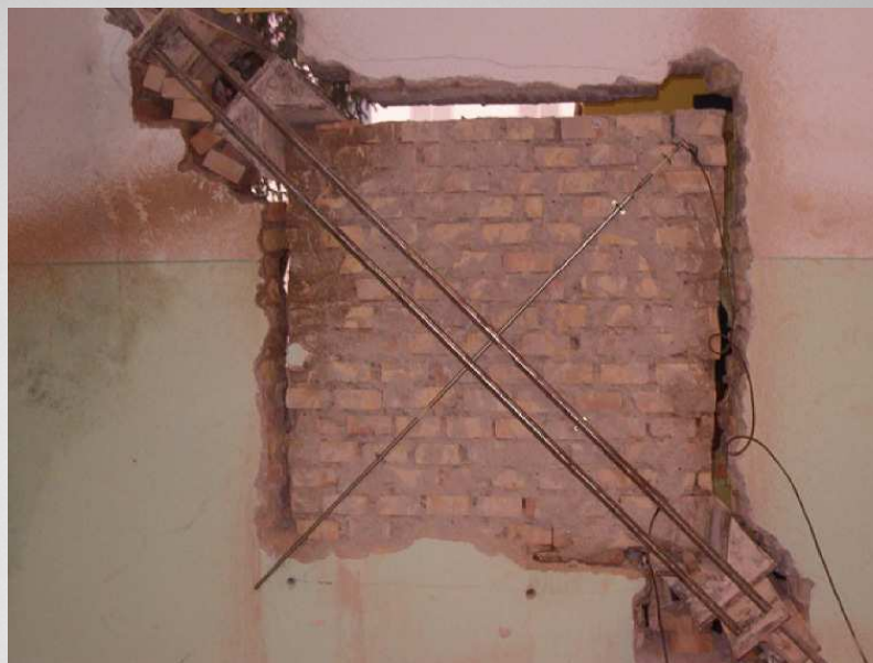
Realizzazione in sito
