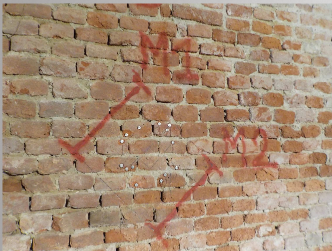
Predisposizione delle basi di misura prima della realizzazione dei tagli
