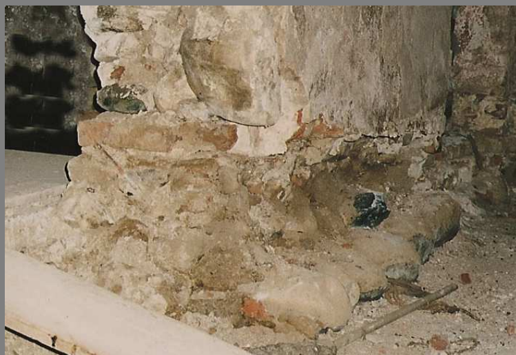
(Sopra ) e (sotto) - Fondazioni di un edificio rurale della pianura saluzzese costituito da stalla e sovrastante fienile
