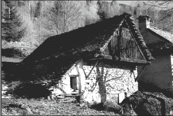
13 13 - Casa ossolana con tetto in piode (Varzo)
