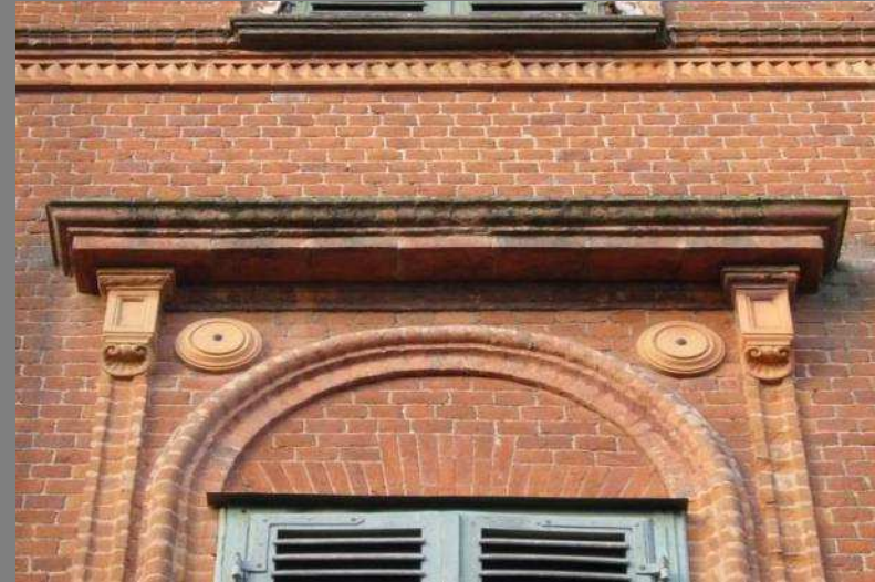
2 – Edificio ottocentesco con paramento a vista, Poirino
