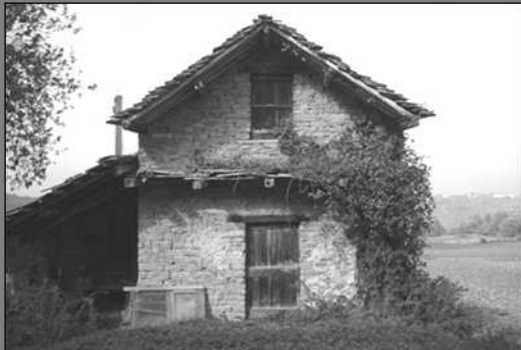
1 1- Cascina delle Alte Langhe con muri e copertura di arenaria (Prunetto)
